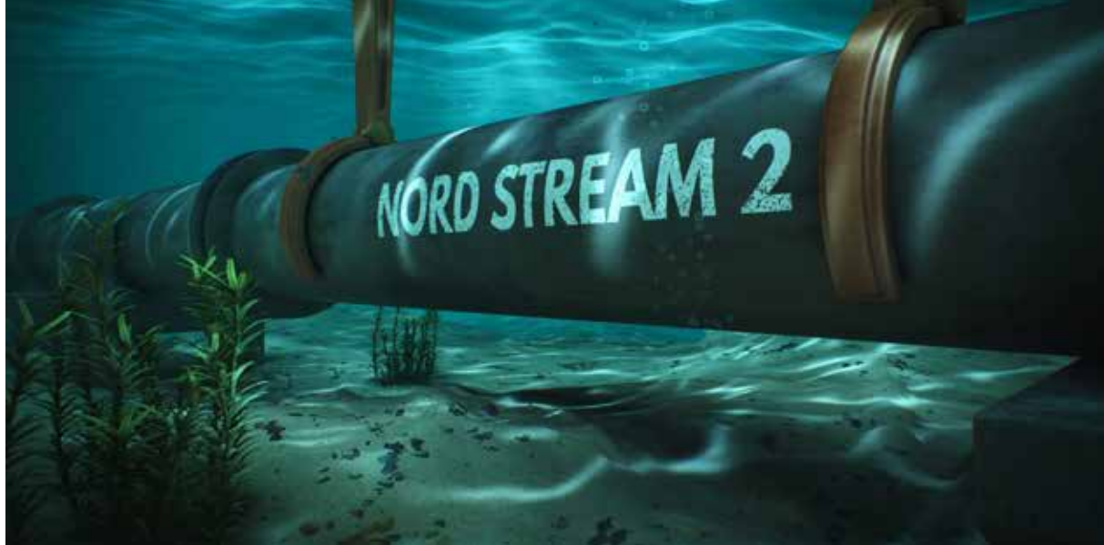
Газопровод «Северный поток – 2»
